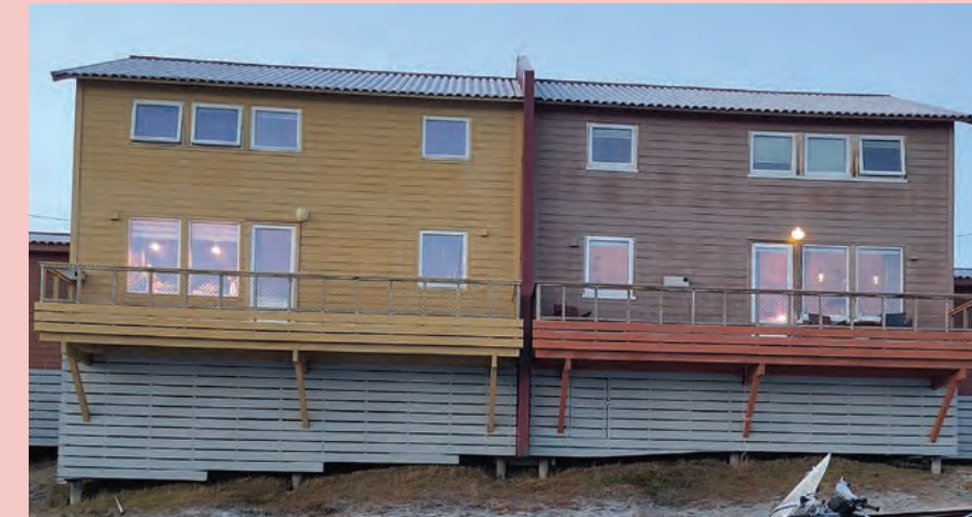
Nye vinduer og dører i hvitt i Gruvedalen. Oppgradering av bygg følger ikke fargeplanen og endrer drastisk på karakteren til byggene. Hvitt er ikke en nøytral farge.
