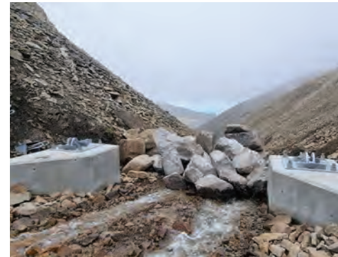
Sikring av Vannledningsdalen
