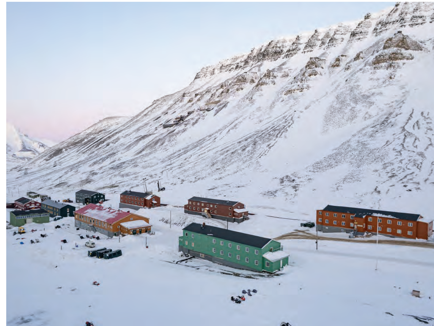
Alle bygg i Nybyen ble oppført i samme periode, dermed er området homogent og har begrenset tidsdybde. Samtidig gjør dette Nybyen til en viktig representant for gjenoppbyggingen etter krigen.
