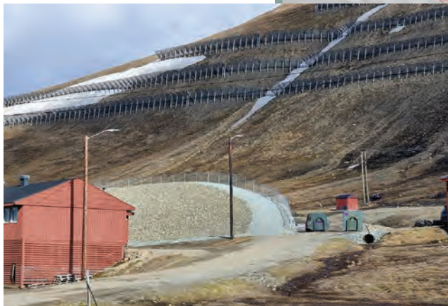
Skredsikring og skredvoll i Lia mot Sukkertoppen Foto: Dina Brode-Roger
